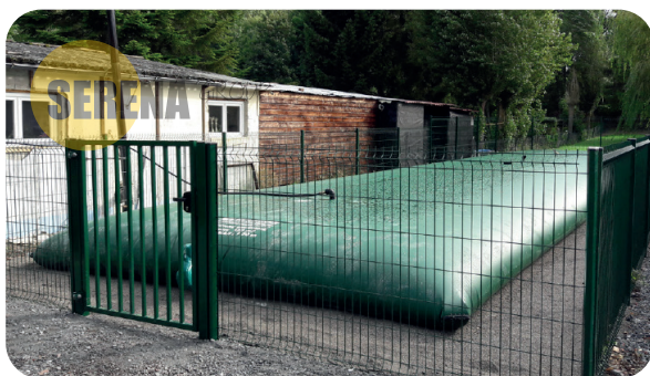
Cisterna za gašenje požara na tleh
